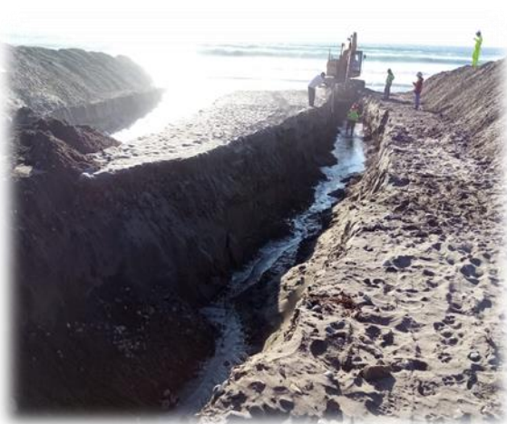
Maniobra de enterramiento del cable FOS realizada en la zona del Intermareal mediante el uso de maquinaria pesada.
