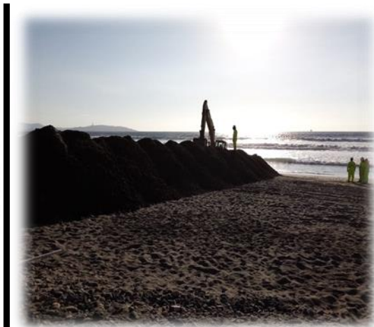
Maniobra de enterramiento del cable FOS realizada en la zona del Intermareal mediante el uso de maquinaria pesada.
