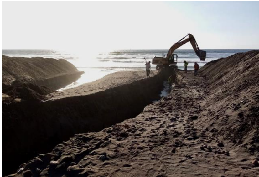
Maniobra de enterramiento del cable FOS realizada en la zona del Intermareal mediante el uso de maquinaria pesada.
